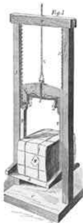
БЕЗОПАСНЫЙ ПОДЪЕМНИК ОТИСА, 1854 г.
